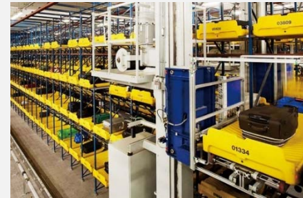
手荷物用自動倉庫
